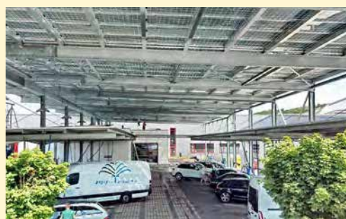
Solardach eines Waschparks in Tübingen
