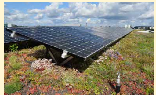
Mit 4,1 m 2 Gründach pro Einwohner*in (Bundesdurchschnitt 1,1 m 2 ) gilt die Landeshauptstadt Stuttgart als bundesweiter Spitzenreiter.
