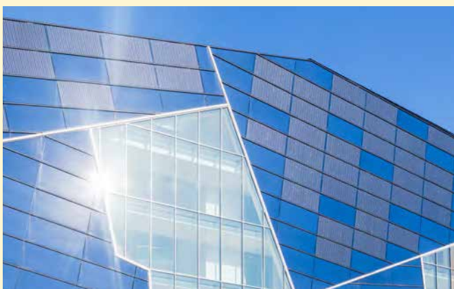
Solarfassade der Volksbank Karlsruhe
